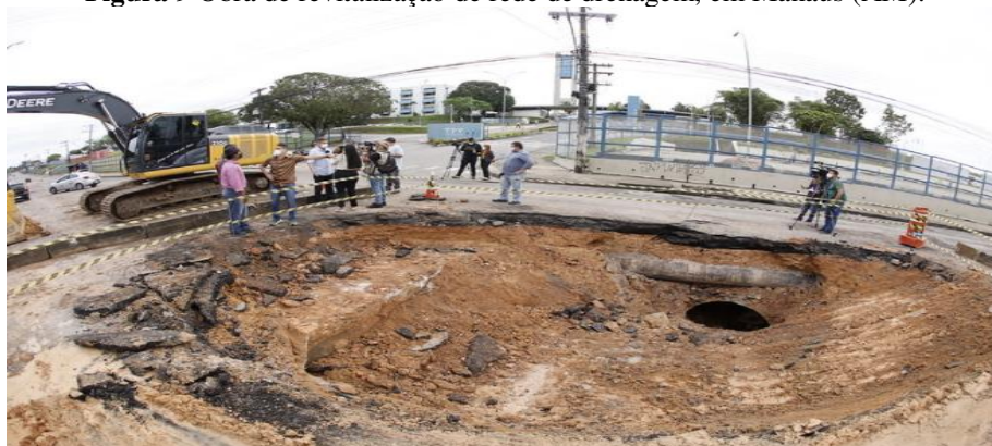
Figura 9 Obra de revitalização de rede de drenagem, em Manaus (AM).
