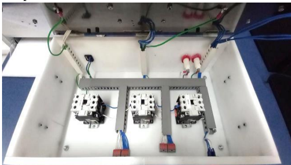
Figura 4.20 - Montagem do sistema de tensão Aplicada. Parte 3.
