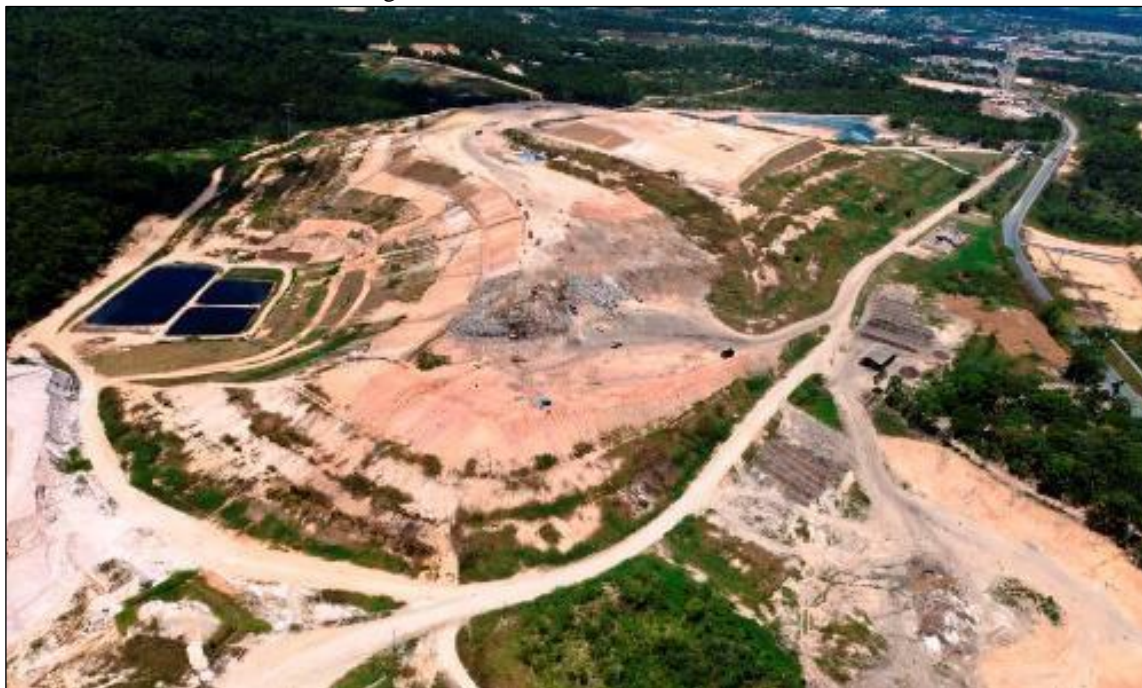
Figura 2.6 - Aterro Sanitário de Manaus.
