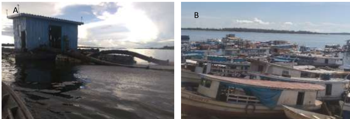
Figura 10. A. Estação de captação de água da Empresa COSANPA. B. Orla portuária da cidade de Oriximiná-PA.
